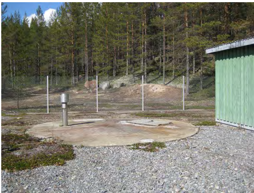
Kuva 1. Nälämön käytössä oleva kuilukaivo.
