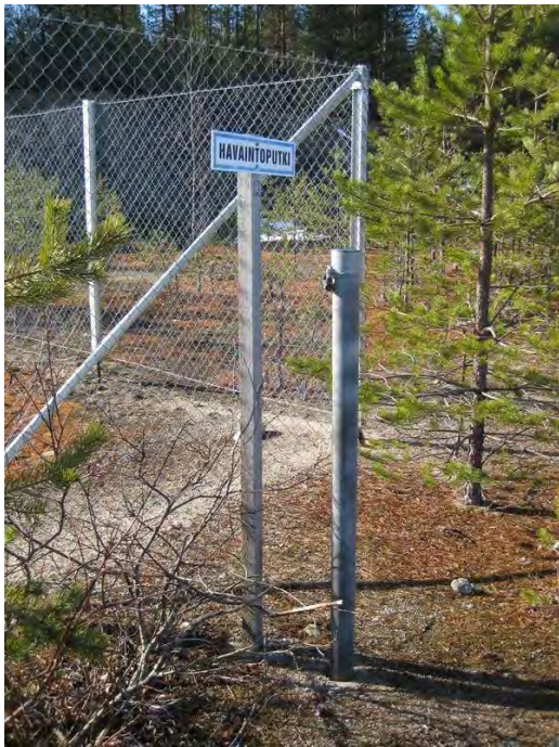
Kuva 3. Pohjaveden havaintoputket on merkitty kyltein. Kuvassa putki HP 12.
