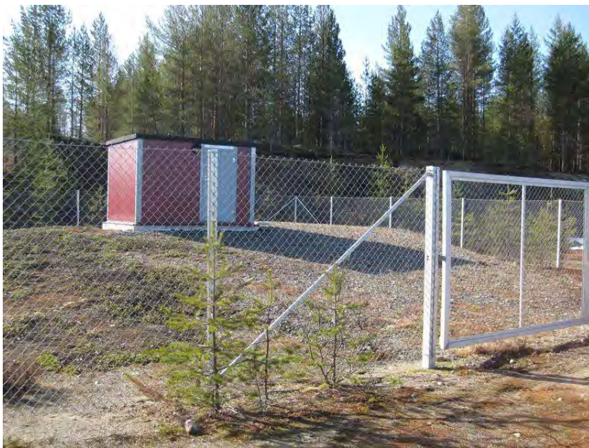
Kuva 2. Kokkokankaan vedenottamon siiviläputkikaivo nro 2.
