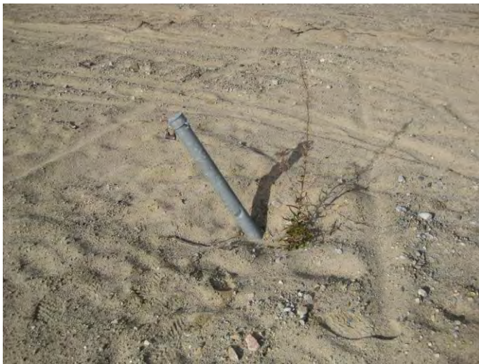
Kuva 7. Taivutunut pohjaveden havaintoputki maa-ainesalueella.
