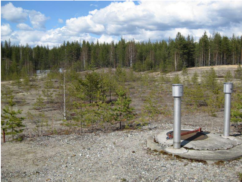
Kuva 2. Nälämön käytössä oleva siiviläputkikaivo.
