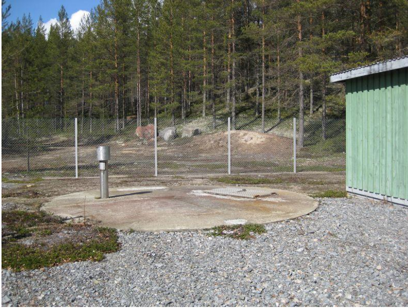
Kuva 1. Nälämön käytössä oleva kuilukaivo.
